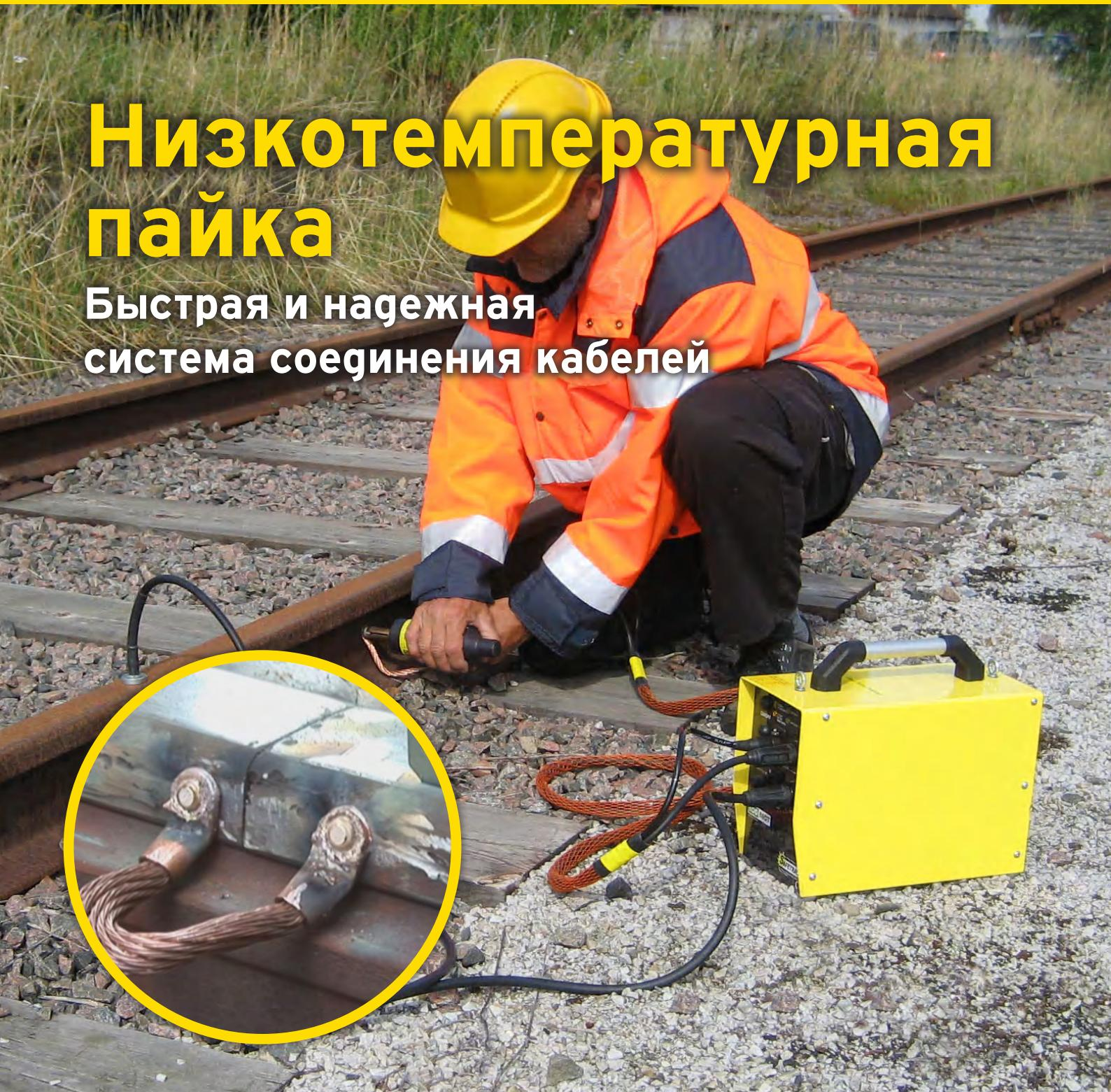
Технология электрического соединения кабелей СЦБ, рельсовых соединителей и заземления для железнодорожного транспорта.
